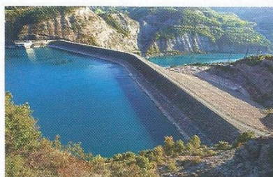
Barrage de Serre-Ponçon (Hautes-Alpes) Production énergétique : 60,2 \cdot 10^3 tep par an.
