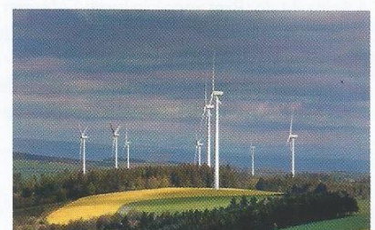
Parc éolien d'Ally-Mercoeur (Haute-Loire) Production durant 6 h de fonctionnement par jour, à la capacité de production maximale de 39 MW.
