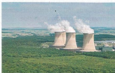
Centrale nucléaire de Cattenom (Moselle) 7 e mondiale en terme de production : 36,73 TWh (2017) grâce à ses quatre réacteurs.
